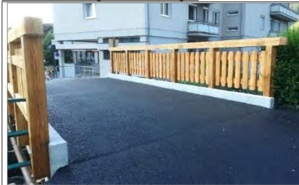
Die **Tenschertbrücke** über den Kaponigbach in Obervellach wurde mit Betonfertigteilen erneuert. Wie bei vielen weiteren Brückenerneuerungen erfolgte die Ausführung über den Gemeindebauhof.
