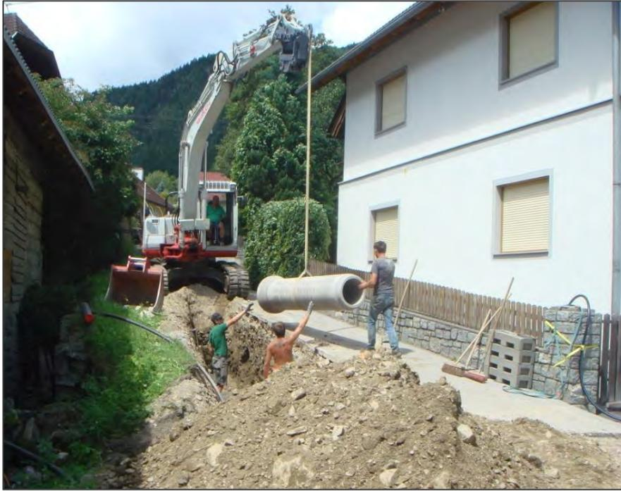
In Semslach wurden umfangreiche Oberflächenwasserkanäle verlegt, um die vorher unkontrollierte Wasserableitung bei Starkregen zu beseitigen sowie die Entstehung von Schäden zu vermeiden. Teilweise erfolgt nun die Wasserableitung in den Semslacher Bach/Mischelbach und teilweise in den Semslacher Dorfbach. Im Zuge der Projektumsetzung wurden umfangreiche Straßensanierungen und Neuasphaltierungen durchgeführt.
