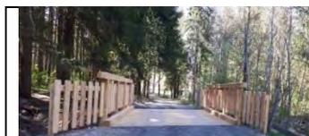
Die bei der **Wunzenbachbrücke** entstandenen Schäden am Widerlager wurden behoben und der Brückenaufbau wurde erneuert.
