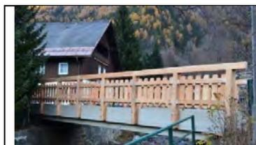
Die **LADERBRÜCKE** (ca. 12,60 m lang) über den Kaponigbach in Obervellach wurde mit Betonfertigteilen erneuert.
