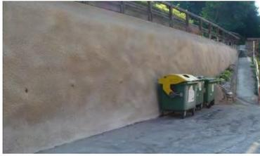
Bei der Römerweg-Stützmauer im Bereich der Kärntnerland-Wohnanlage in Räuflach 44 bis 47 traten kleinere Setzungen auf, die Mauer wies Ausbuchtungen auf und es bestand die Gefahr, dass Steine herausfallen. Daher hat die Gemeinde nach örtlicher Besichtigung und fachlicher Beurteilung die erforderliche Sanierung dieser Mauer beschlossen. Die Auftragsvergabe erfolgte an die Firma ETM
